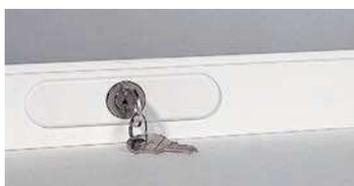
Avec serrure sur lame intermédiaire à 700 mm du bas sur volet à tirage direct.
