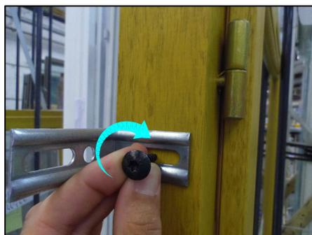
Visser la vis de 30 fournie avec un embout Torx, la placer au milieu du trou oblong.
